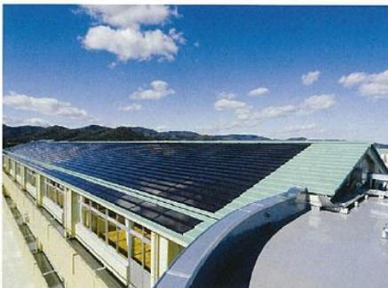
校舎屋根に40kWの太陽光パネルを設置
